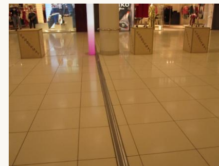
Пример подвижного шва в торговом центре
