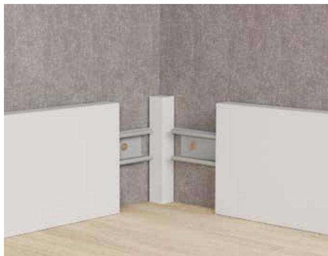
Установка соединительного столбика
