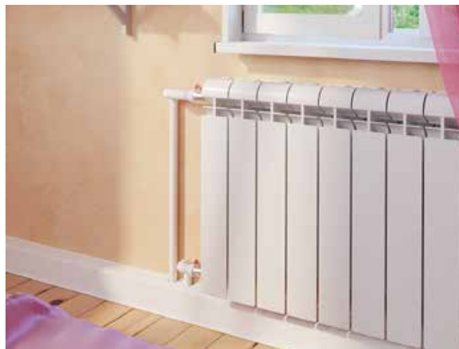
Установка плинтуса с боковым подключением к радиатору
